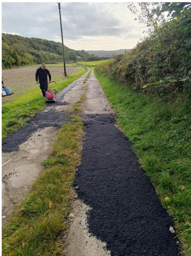
Plusieurs tonnes d'enrobé ont été nécessaire à la réfection de la rue des bleds à Watterdal.
