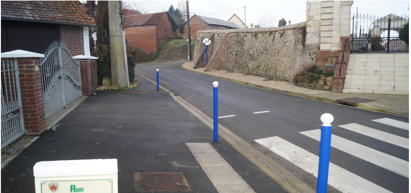
La rue des creuses en chantier pour cette année. - VDN
