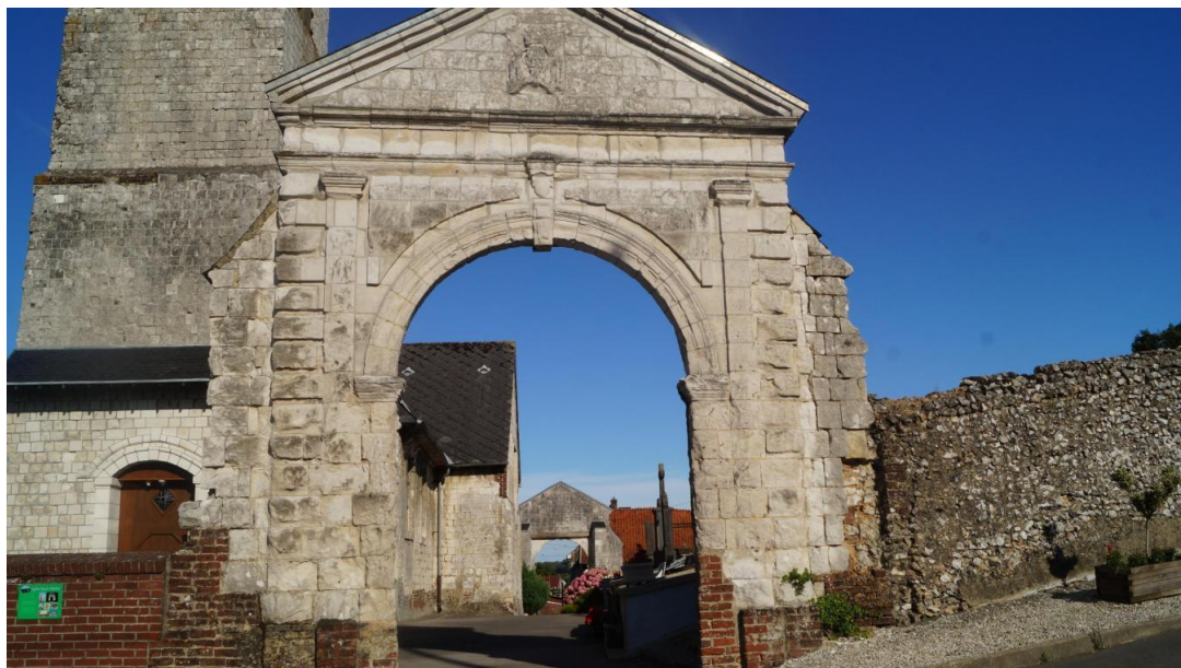
Le porche de l'entrée ouest restauré en 2011.
